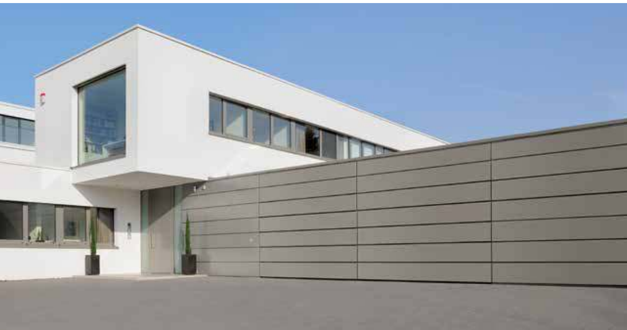
Bauseitige Beplankung mit Aluminium-Verbundplatten
